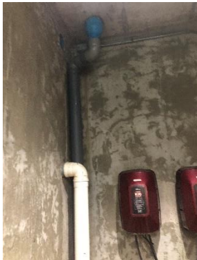
Foto N°23: Instalación de ducto de descarga de aguas lluvias que entran por la rejilla de ventilación.
